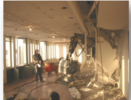
Démolition avec robots
