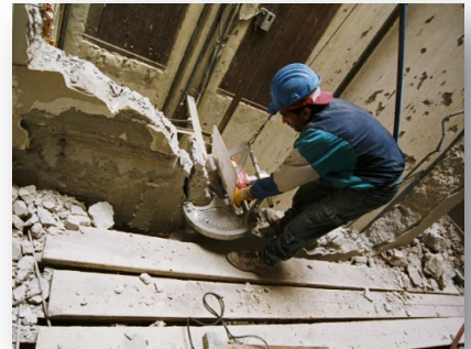
Démolition avec outils à main
